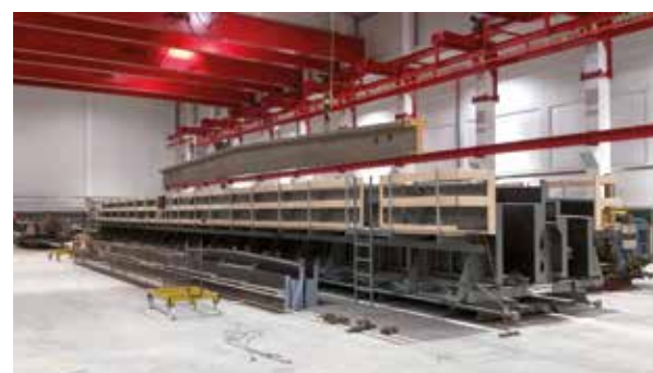
Cofraj pentru grinzi
