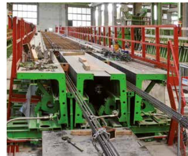
Cofraj pentru elemente TT
