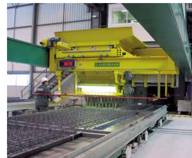
Betonare și compactare
